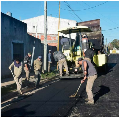
Obras y Servicios Públicos
