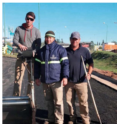
Obras y Servicios Públicos
