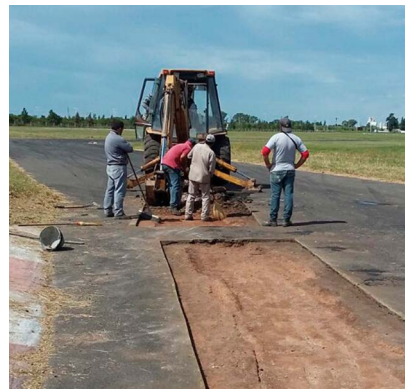
Obras y Servicios Públicos
